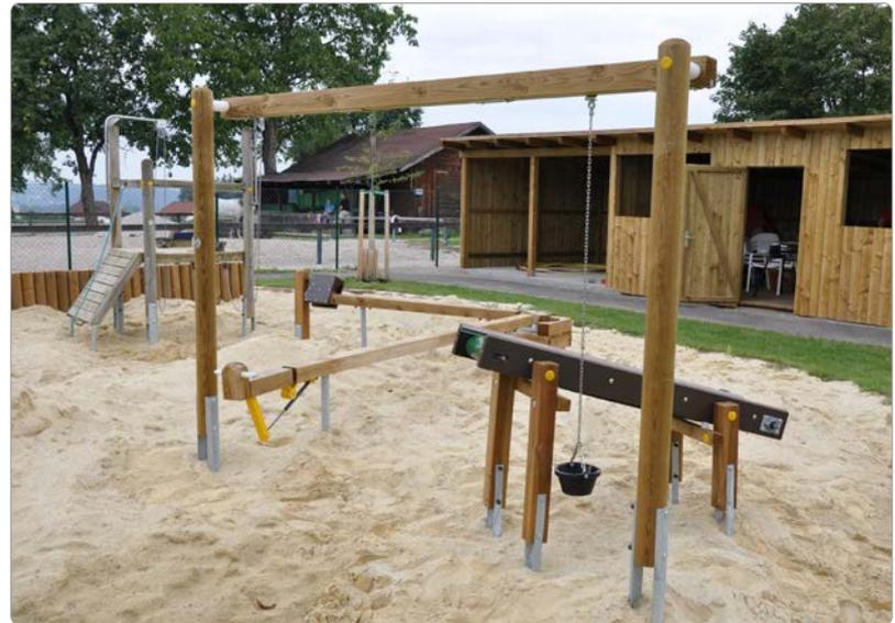
Beschreibung: 2 Steher (Pfosten), Rundhölzer Ø 12 cm, 1 Kantholz 9/11 cm mit Laufschiene in Nut, 1 Sandtransport-Laufwagen mit Ketten-Abhängung, 1 Sandbehälter aus Gummi.
