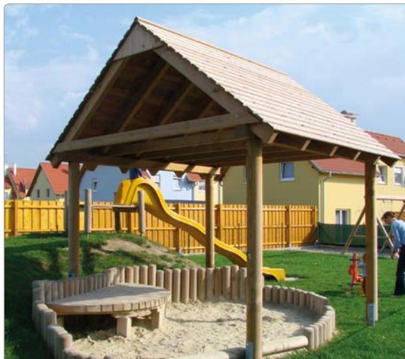
Beschreibung: Steher aus Rundhölzern  $\varnothing$  14 cm, kerngetrennt (kernfrei), aufgeständert mit Stahlschuhen, verzinkt, Pfetten aus Kanthölzern 11/11 cm, Sparren aus Kanthölzern 7/13 cm, Zangen aus Kanthölzern 4/11 cm, Dacheindeckung mit Holzschalung, gefalzt und genietet, Schrauben verzinkt.
