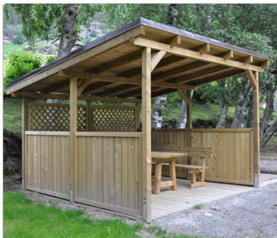
Beschreibung: Konstruktion aus Kanthölzern 9/9 und 9/11 cm kerngetrennt (kernfrei), Bodenverankerung mit Stahlschuhen, verzinkt, volle Dachschalung, umlaufendes Stirnbrett am Dachsaum, Wandelemente als Rahmenzaun ausgebildet, mit senkrechter und/oder diagonaler Lattenfüllung, Dacheindeckung nach Wahl, entweder mit Kunststoffolie oder mit verzinktem Blech, Schrauben verzinkt. Verankerungspunkte: 4 Stk.
